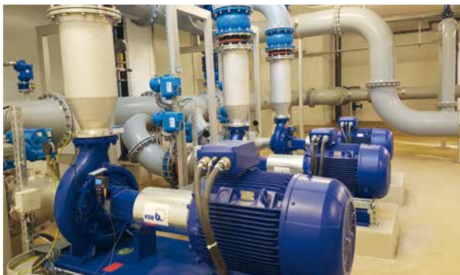
Die Reinwasserpumpen fördern das Trinkwasser Richtung Innenstadt und Kirchmöser.
