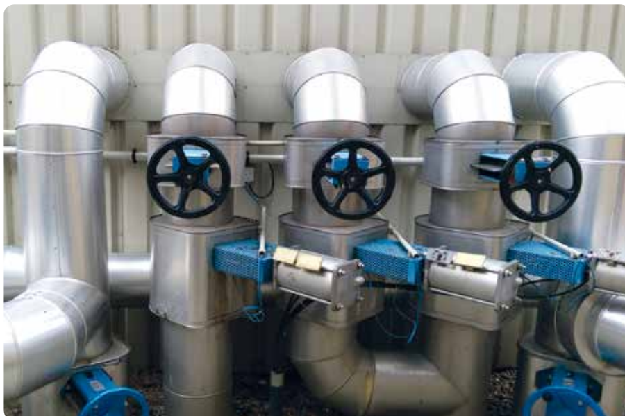
Durch diese Leitungen gelangt der Schlamm in die Faultürme.
