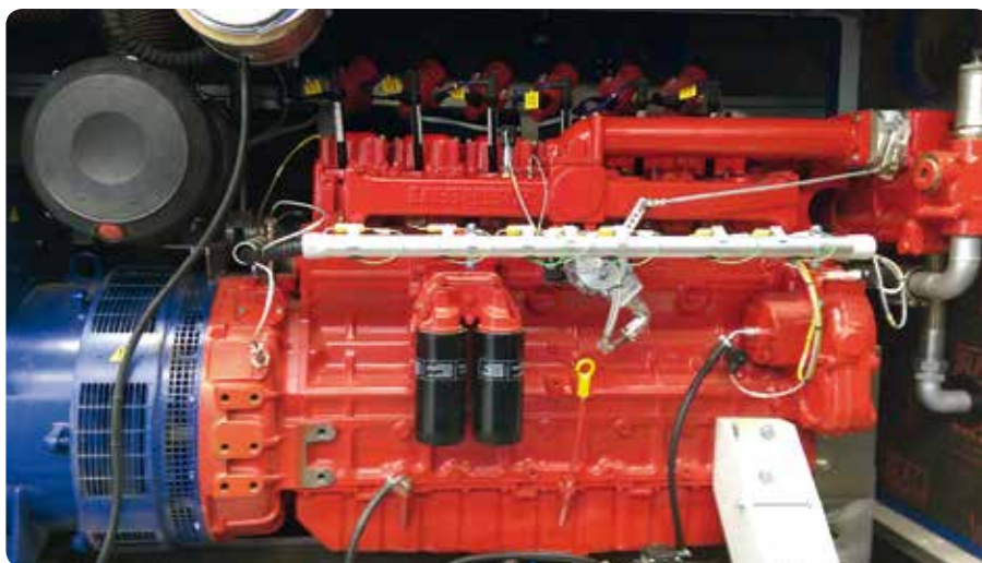
Blick ins Innere des Blockheizkraftwerks
