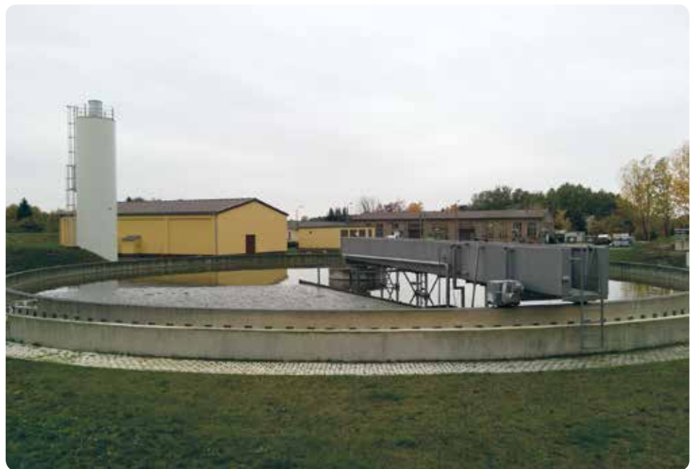
Im Vorklärbecken wird der größte Teil des Klärschlammes gewonnen.
