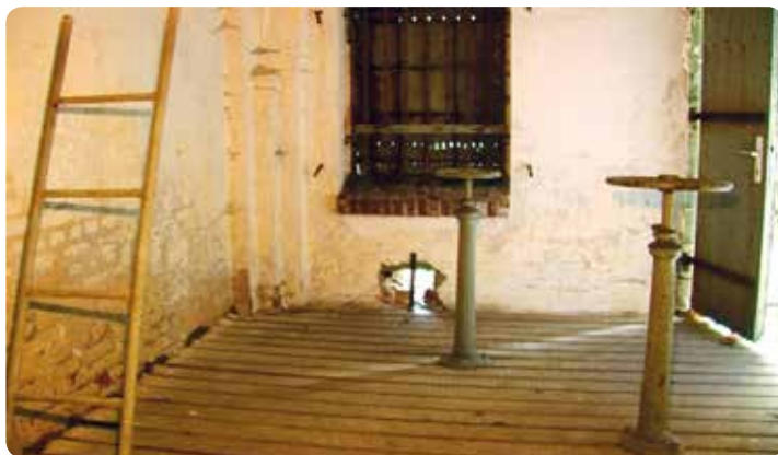
Das Schiebergebäude vor der Sanierung, 2011
