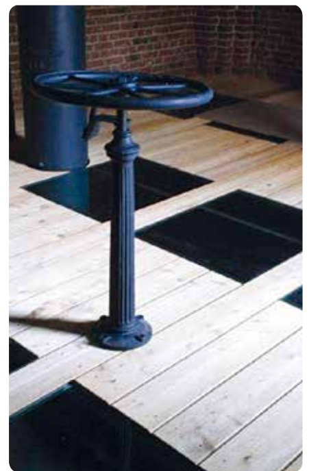
Das Schiebergebäude nach der Sanierung, 2014
