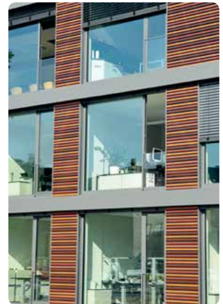
Die farbenfrohe Fassade integriert sich gut in das Stadtbild.
