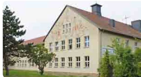
Die sanierte Klingenbergsschule (Foto: SKE)
