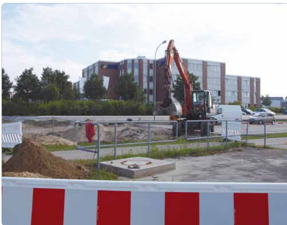
Alle Richtungen gesperrt, nichts geht mehr – auch für die Stadtwerke
