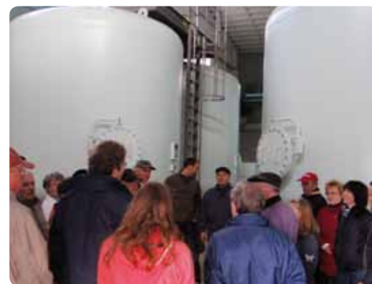
Blick auf die Enteisenungsfilter
