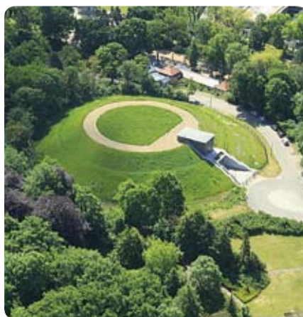
Trinkwasserhochbehälter auf dem Marienberg
