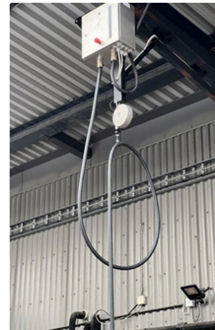
Abbildung 17: CCS Anschlussbox mit Seilzug-Abrollsystem
