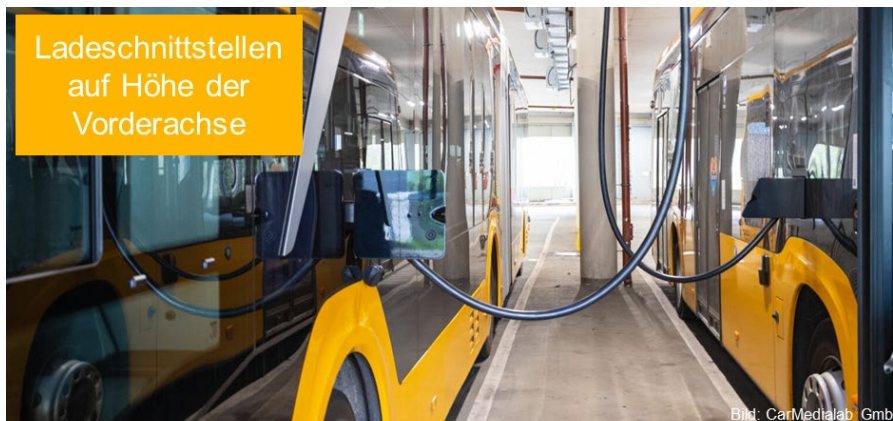
Abbildung 20: Praxisbeispiel mit beidseitigen Ladeschnittstellen auf Höhe der Vorderachse
