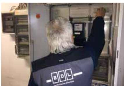
Durch das Erfassen von Zählerständen kann eine genaue Abrechnung erfolgen.
