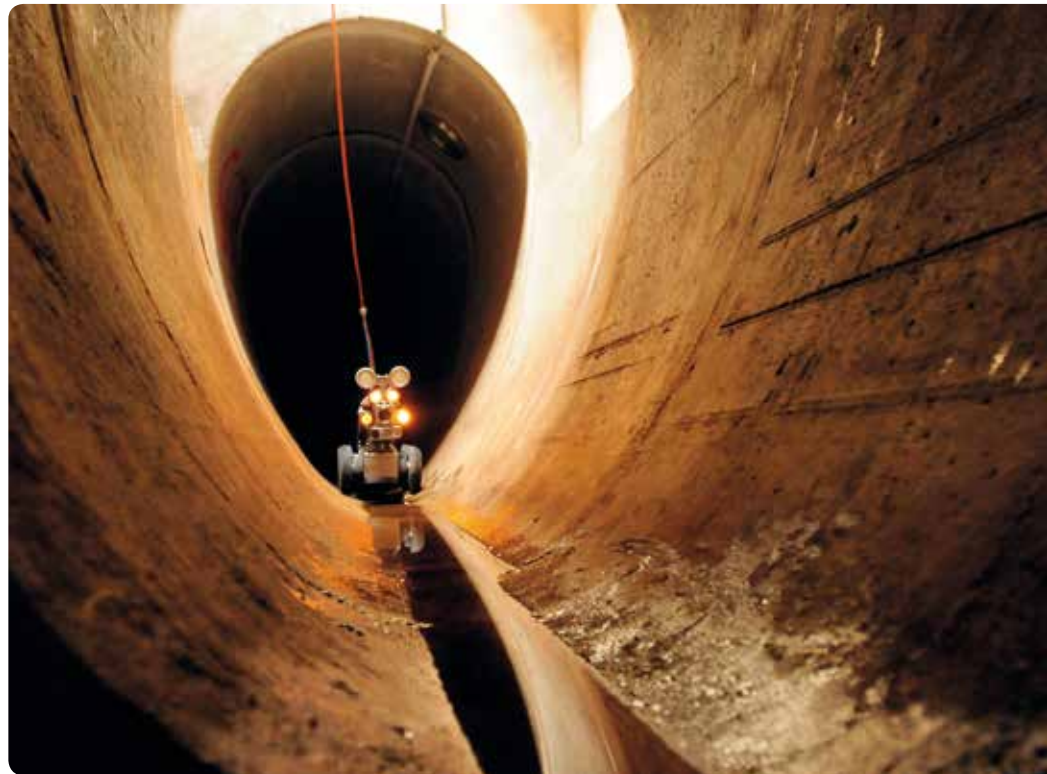
In aufwendigen Kamerafahrten werden eventuelle Schwachstellen analysiert
