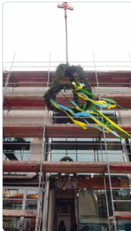
Das Richtfest ist der traditionelle Dank an die Handwerker
