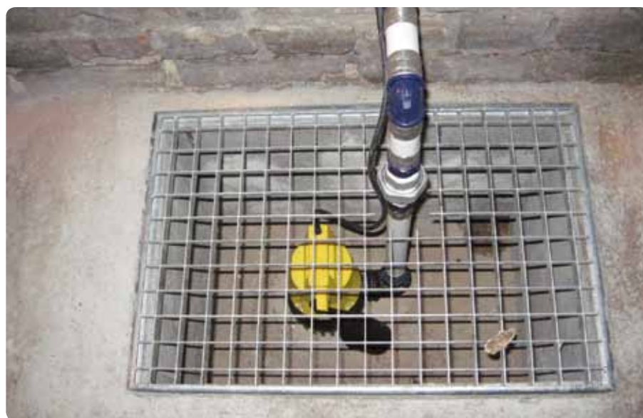
Grube im Kellerfußboden mit Pumpe und Rohr zur Ableitung des Grundwassers
