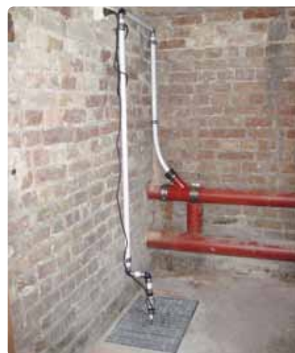
Leitung zur Abführung des Grundwassers
