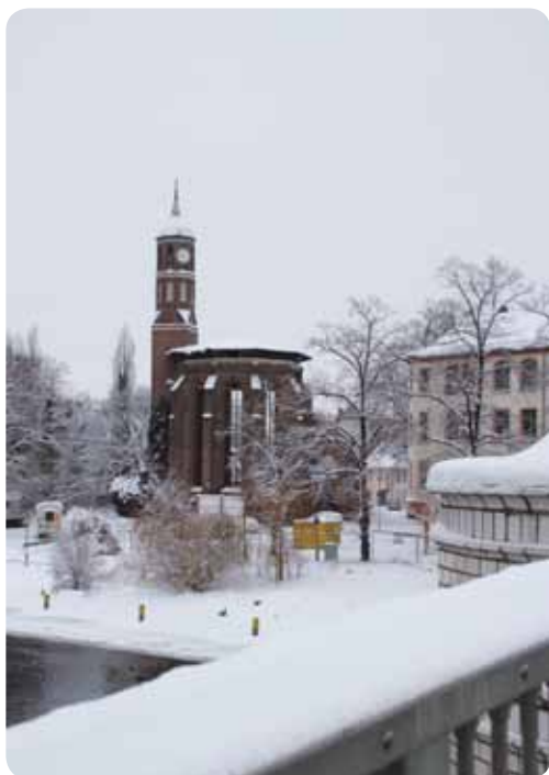
Wohnen in unmittelbarer Nähe zur Havel - Grundwasser im Keller gehört aber meist dazu
