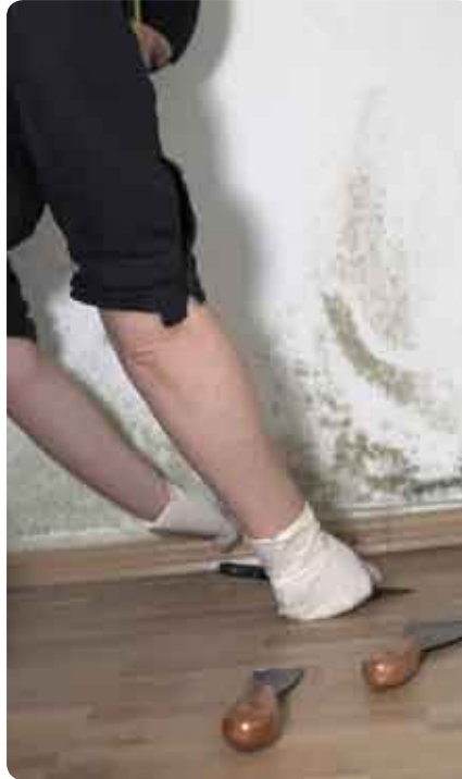
Großflächiger Schimmelpilzbefall sollte von einem Fachmann entfernt werden.
